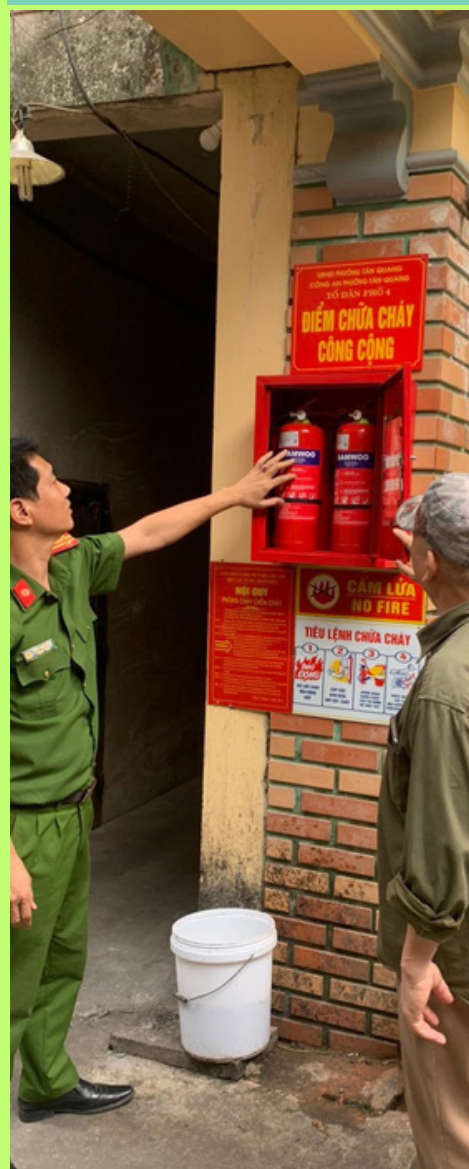
LẮP ĐẶT ĐIỂM CHỮA CHÁY CÔNG CỘNG
